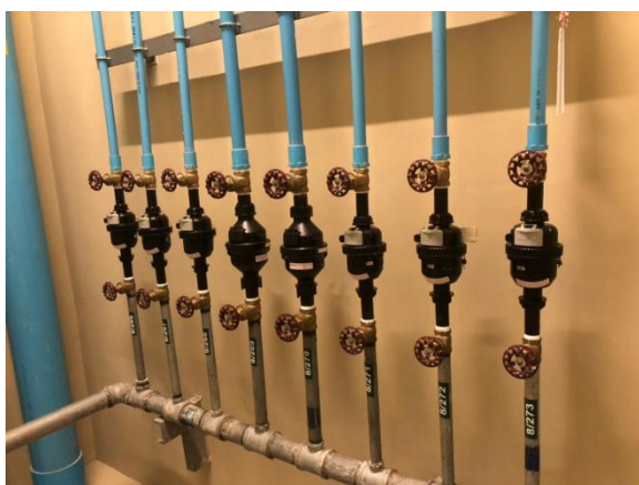
รูปที่ 2-59 มิเตอร์น้ำแต่ละชั้น
