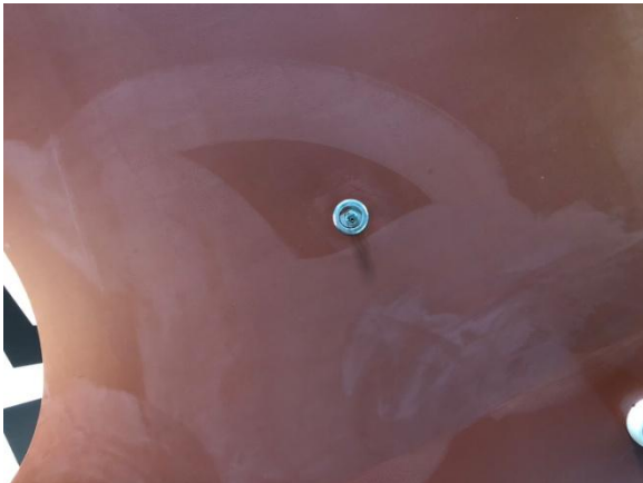
รูปที่ 2-23 หัวกระจายน้ำดับเพลิง
