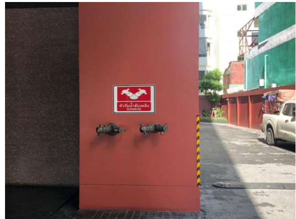
รูปที่ 2-28 หัวรับน้ำดับเพลิงด้านหน้าโครงการ
