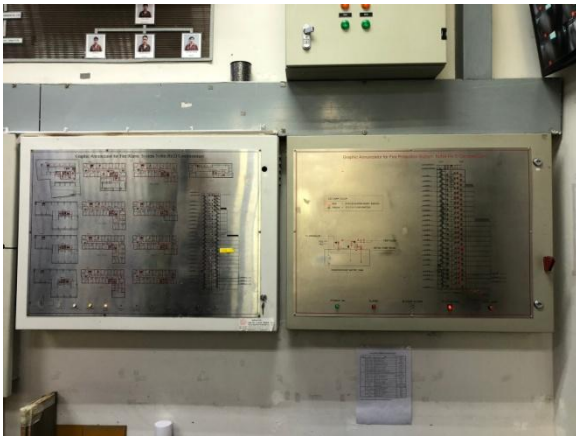
รูปที่ 2-35 ตู้ควบคุมระบบป้องกันอัคคีภัย
